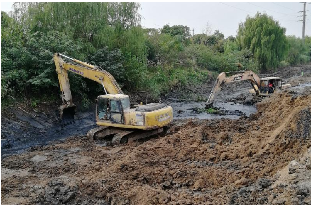
施工现场照片
